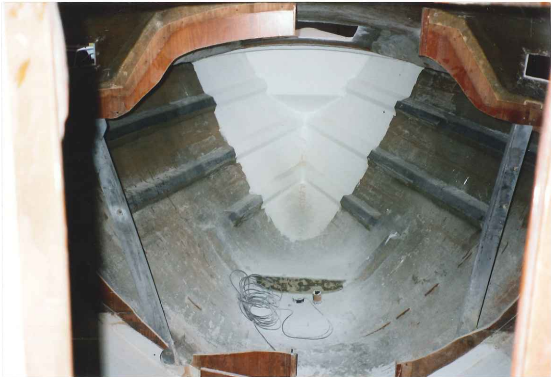
Vorschritt mit Stringern und neuem Ankerkasten
