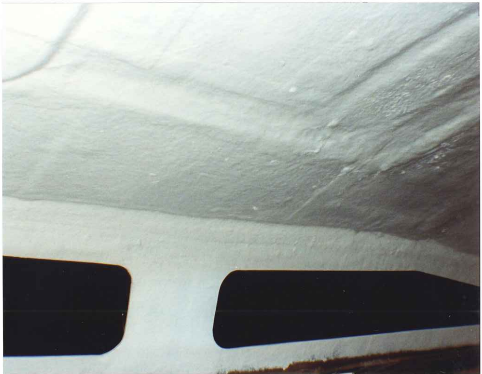
Decke überholt inklusive neuer Verstärkungen, neuer Fenstersteg
